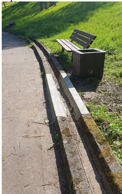
Lietaus nuvedimo latakų remontas Nemuno krantinėje
