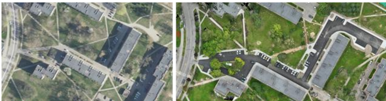
pav. 94. Automobilių stovėjimo aikštelės Vytauto g. darbai
