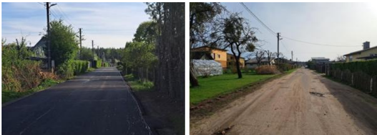
pav. 55. Paklota nauja asfalto danga Paparčių g. Viečiūnų miestelyje
