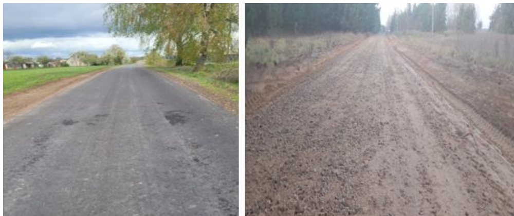
pav. 67. Įrengta nauja asfaltbetonio danga
