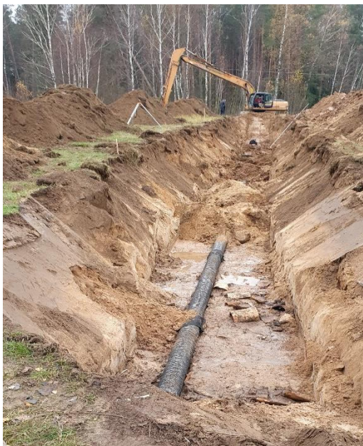
Pav. 108. Remontuojama drenažo sistema
