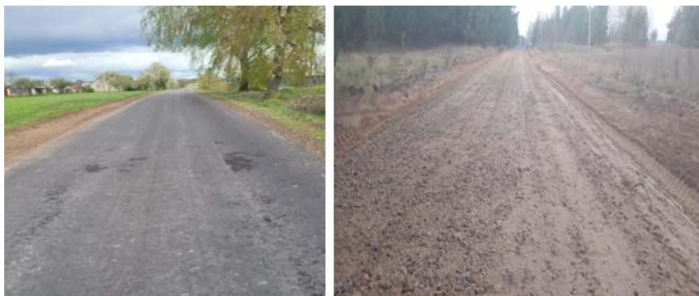
pav. 67. Įrengta nauja asfaltbetonio dangą
