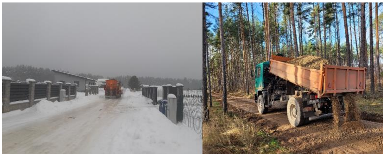
Pav. 40. Kelių priežiūra žiemos metu / kelių danga gerinama skalda
