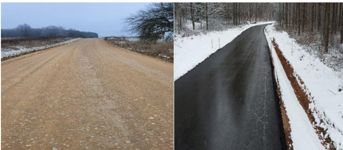
Pav. 46. Leipalingis -Didžiasalis įrengtas skaldos ir žvyro pagrindu bei naujai paklota asfalto dangą link Vilkanastrų kaimo
