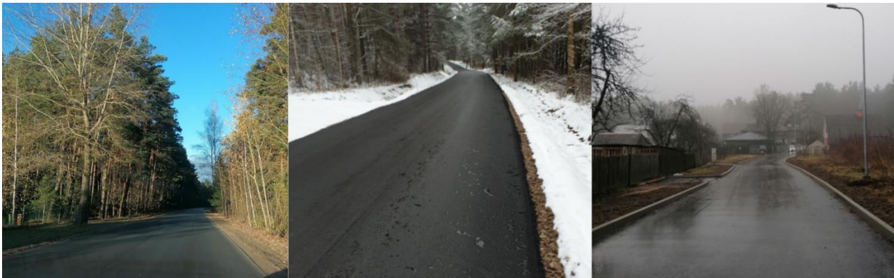
Pav. 87. Baltašiškės, Černiauskų g. ir Kalnų g. Gatvių asfaltavimo darbai
