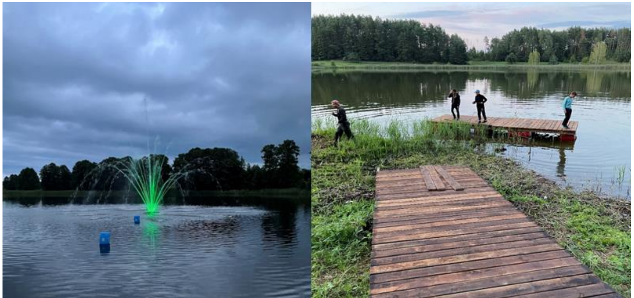
Pav. 62. Įrengtas fontanas ir padarytas pontoninis tiltas
