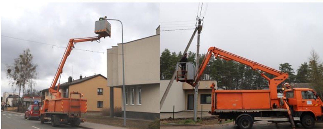
Pav. 94. Gatvių apšvietimo rekonstrukcijos darbai
