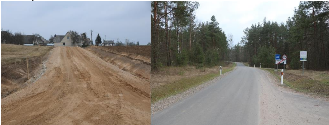
Pav. 47. Naujosios gatvės privažiavimas / naujai paklota asfalto danga link Vilkanastrų kaimo
