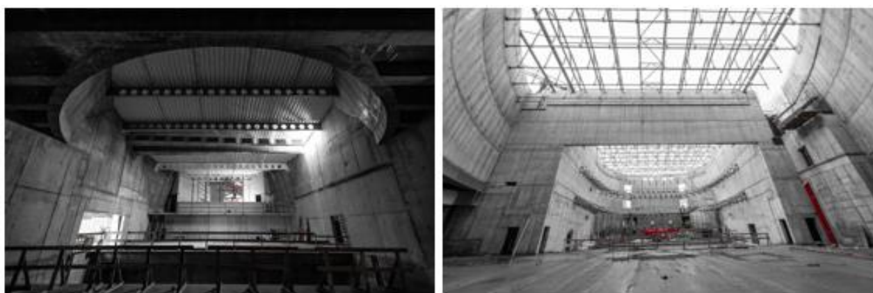
Pav. 105. Kultūros centro statybos
