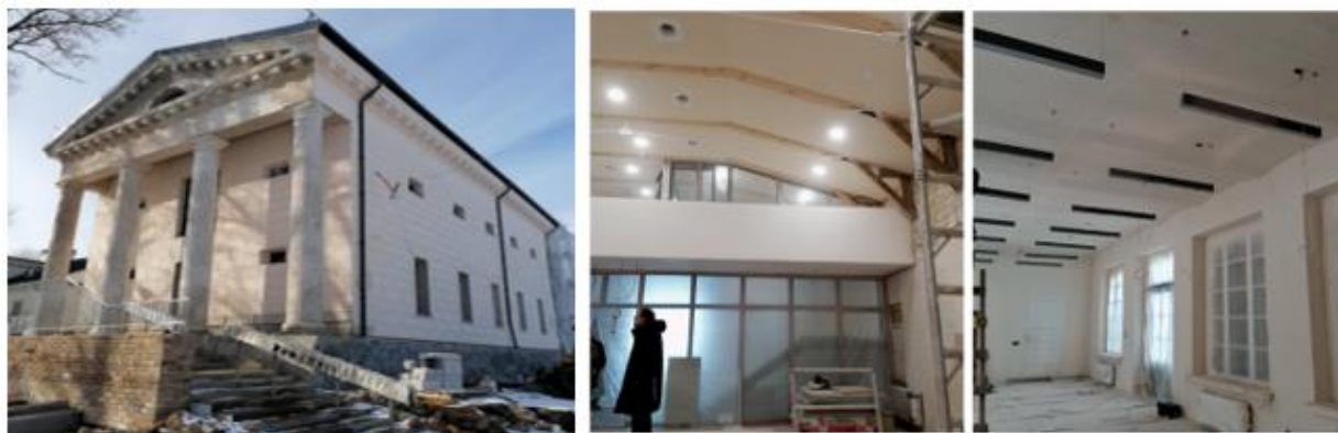
Pav. 107. Leipalingio dvaro remonto darbai
